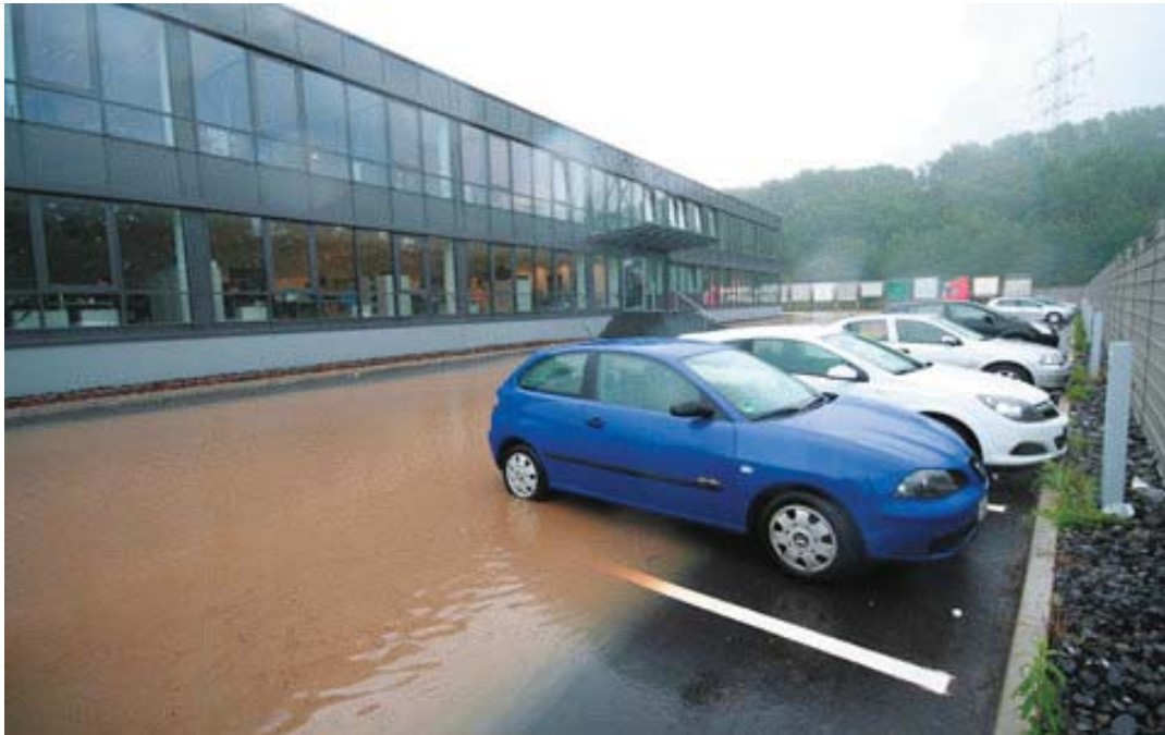
Bild 14-121 Teilweise kurzfristig überfluteter Parkplatz ohne Schadensverursachung Bildnachweis: Kaiseringenieure, Dortmund
