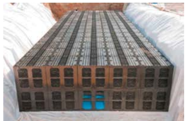
Bild 14-134 Beispiel für eine mit Filtervlies ummantelte Boxen-Rigole für die Niederschlagswasserversickerung Werkbild: REHAU, Erlangen
