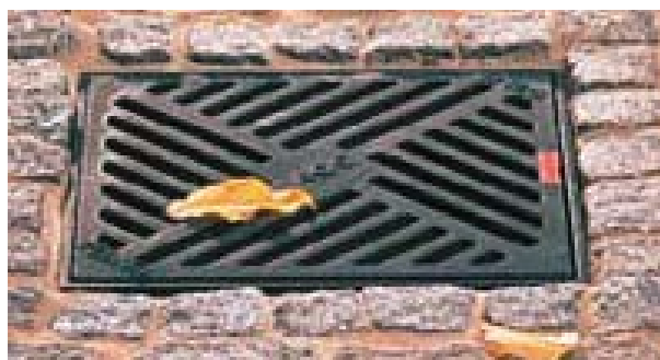
Bild 5-12 Hofablauf mit einer 1,0 m im Umkreis befestigten Fläche Werkbild: ACO Passavant GmbH, Philippsthal
