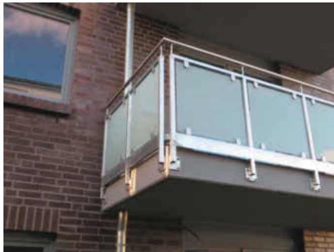
Bild 5-38 Balkon mit offener Brüstung mit Glaselementen
