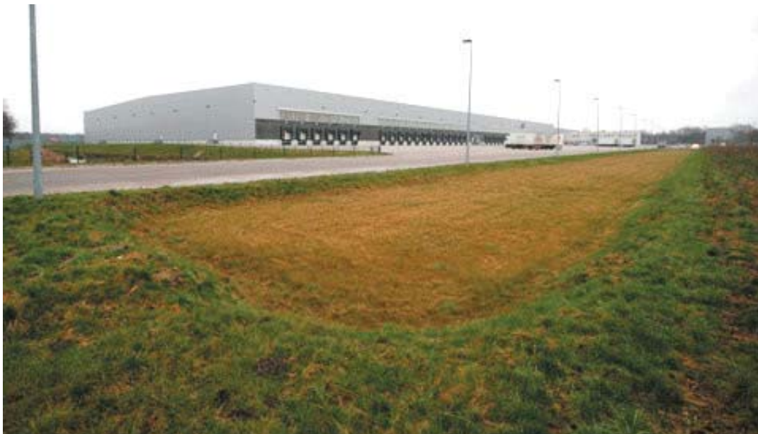
Bild 14-122 Gewerbehalle und Fahrflächen mit Muldenanlage zur Aufnahme des Niederschlagswassers im Überflutungsfall Bildnachweis: Kaiseringenieure, Dortmund
