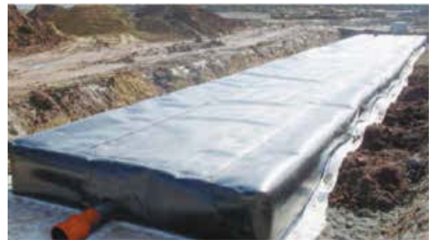
Bild 14-133 Beispiel für einen mit einer Dichtungsbahn geschlossenen Niederschlagswasserspeicher Werkbild: REHAU, Erlangen
