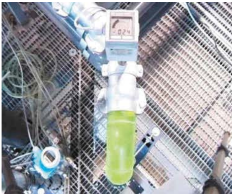
Bild 14-75 Messstelle für den statischen Innendruck ( p_x = 241 \text{ hPa} )
